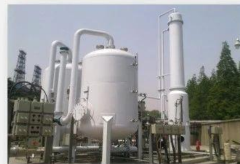
铁路装车VOCs回收-活性炭吸附
